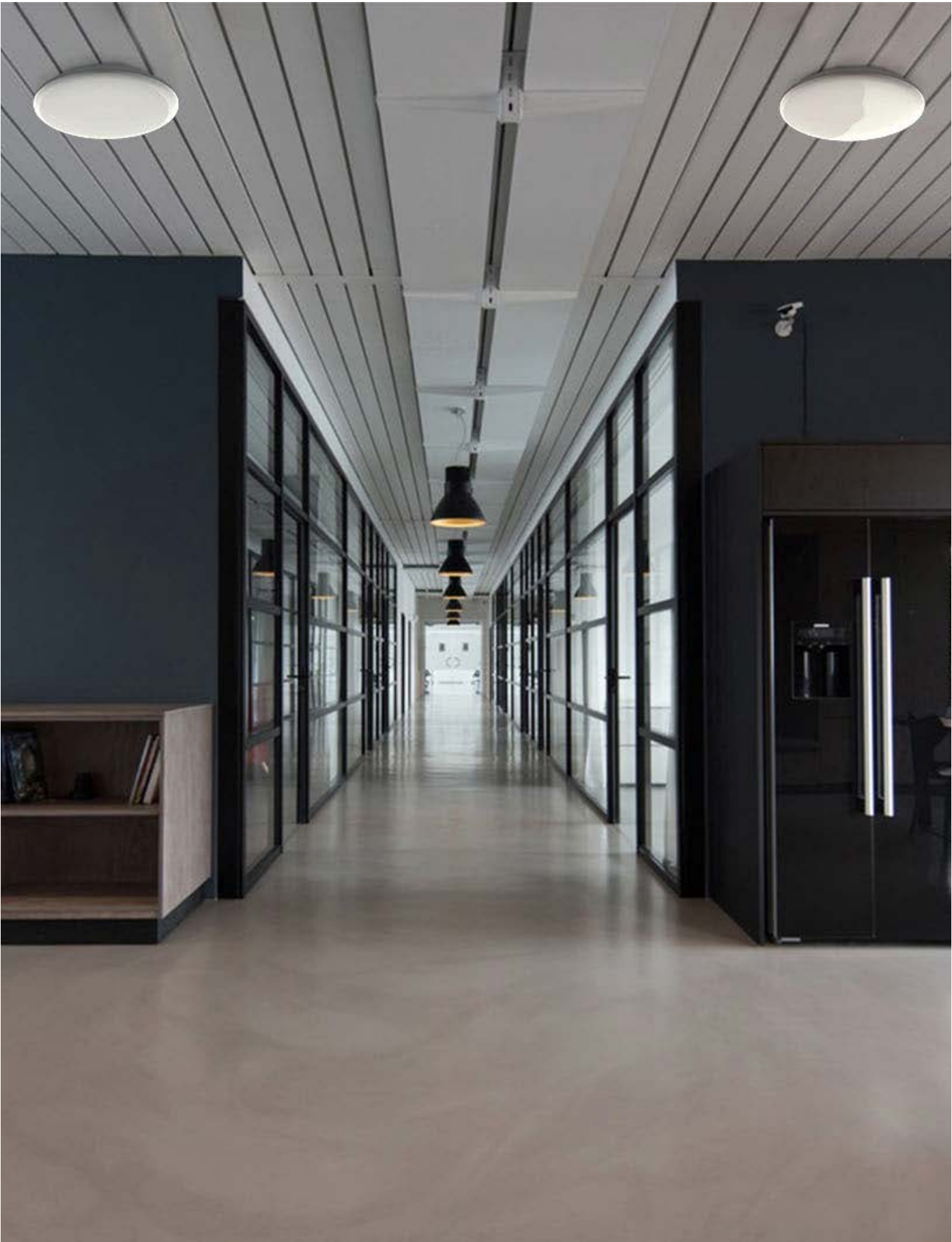
Una LED Taklampe monteret i fellesområde.
